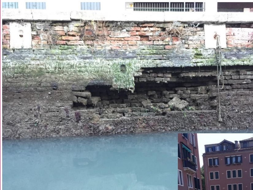
intervento in corso
