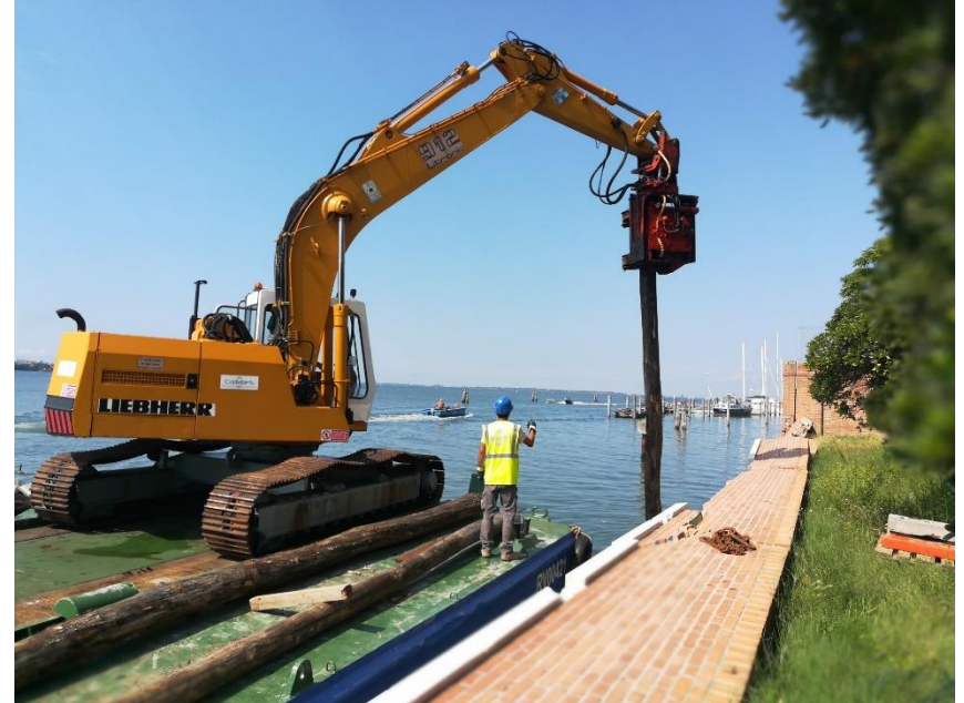
durante i lavori
