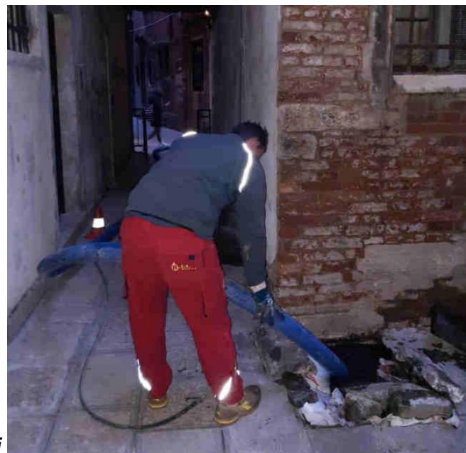
durante i lavori
