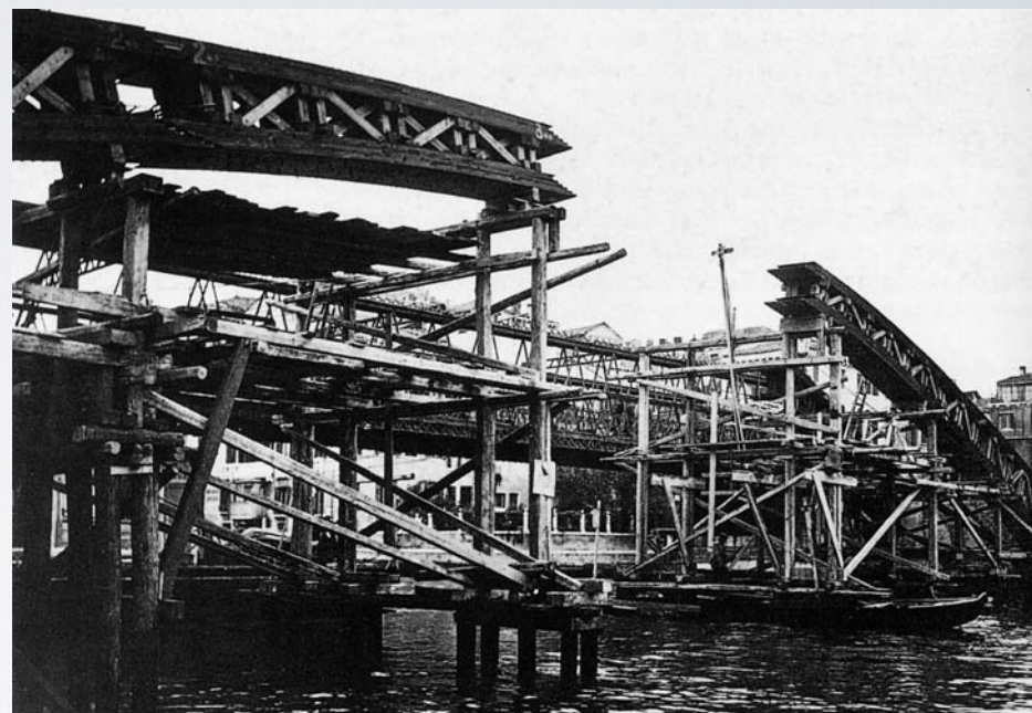
10. 1933, Eugenio Miozzi, il ponte provvisorio in costruzione affianca il precedente ponte Neville
