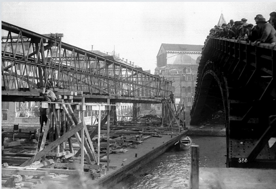
13. 1933 : smantellamento del ponte Neville
