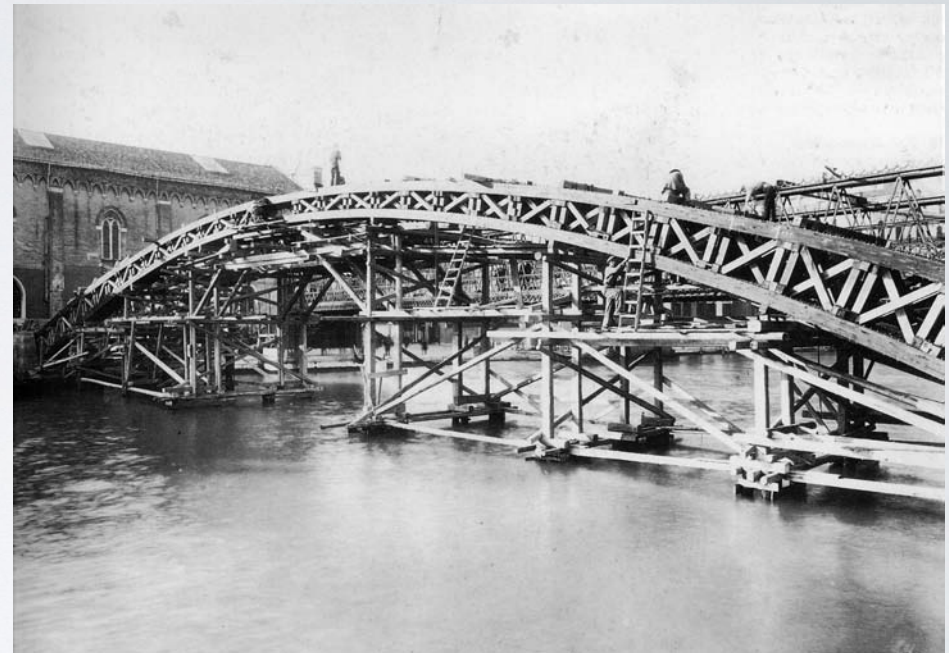
12. 1933, Eugenio Miozzi, il ponte provvisorio in costruzione affianca il precedente ponte Neville
