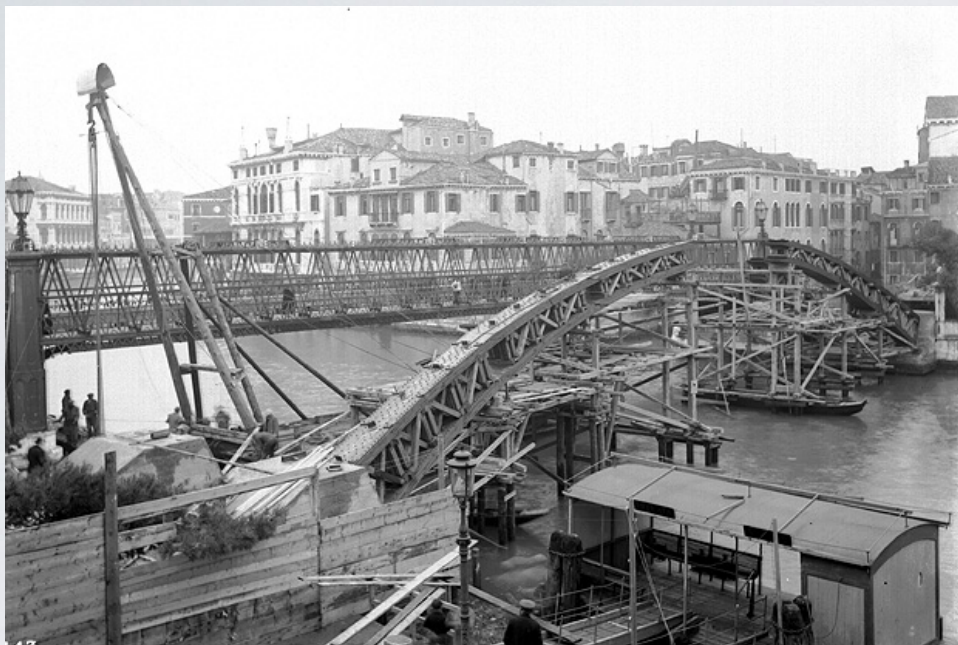
9. 1933, Eugenio Miozzi, il ponte provvisorio in costruzione affianca il precedente ponte Neville
