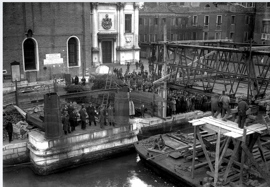
14. 1933 : smantellamento del ponte Neville
