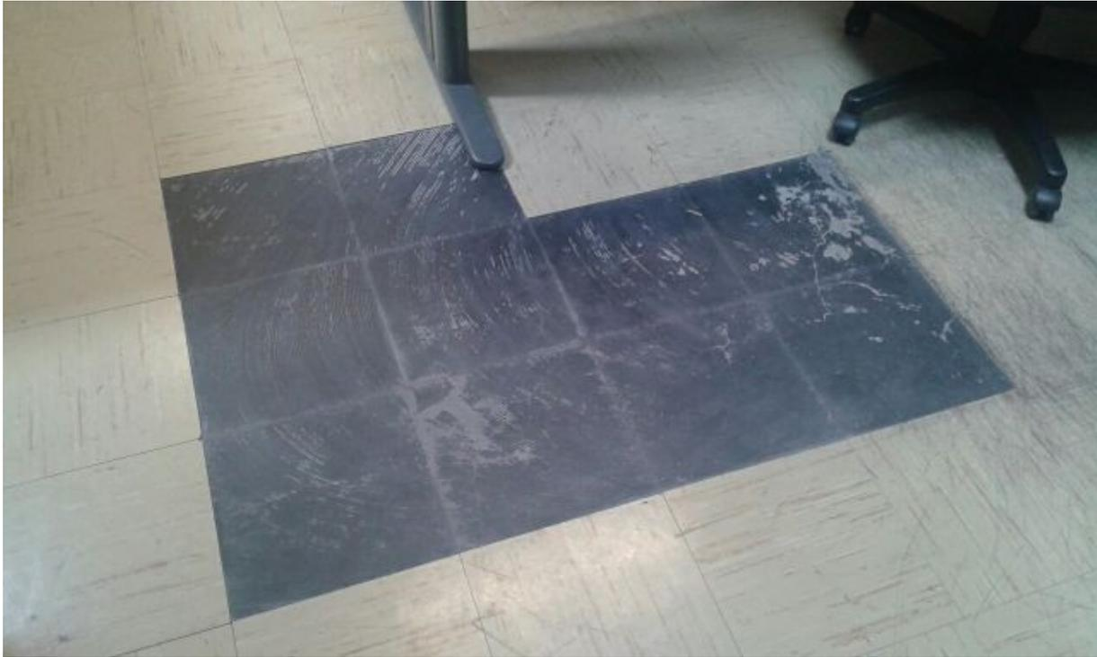
*Figura 5 Esempio di pavimento e colla contenente fibre di amianto*
