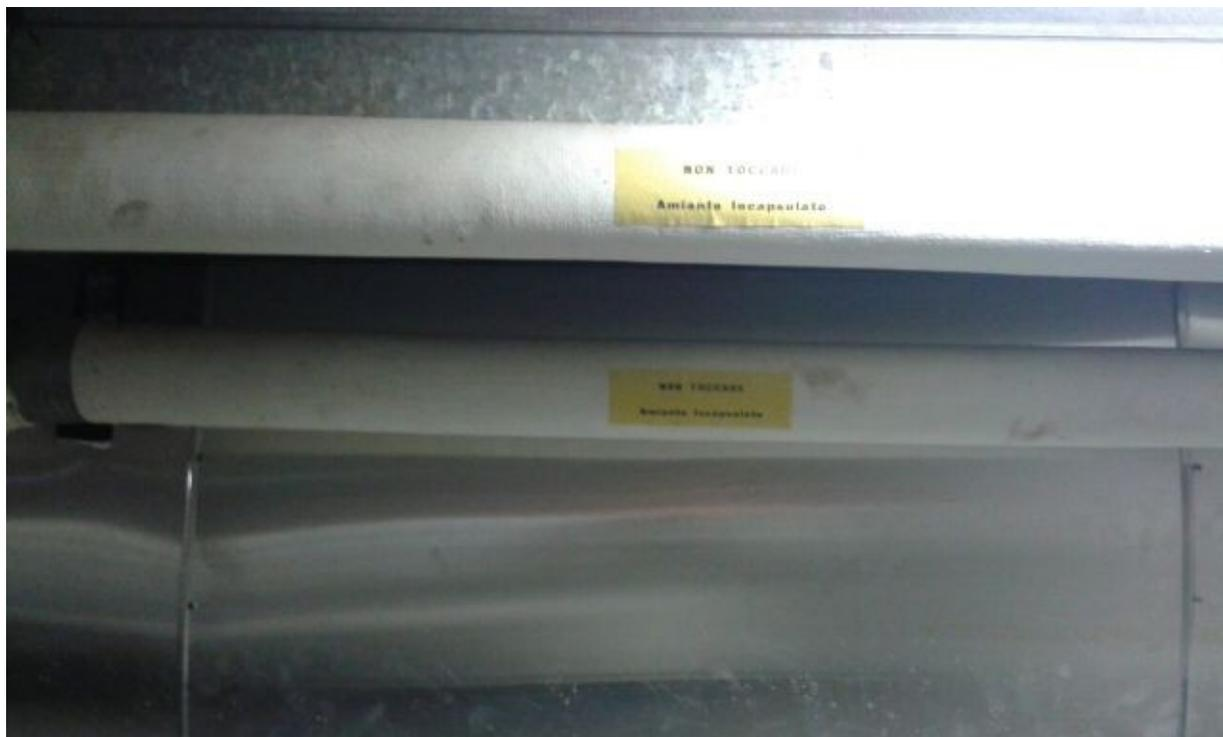
Figura 2 esempio di manufatto in amianto segnalato con apposita etichetta.
