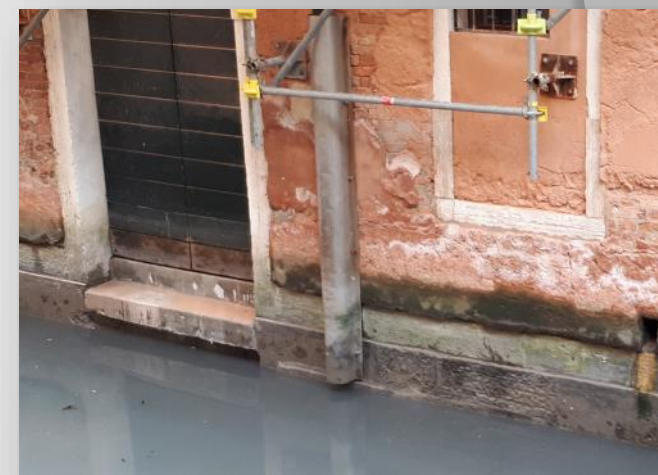
Interventi di presidio delle porte d'acqua già realizzati da Generali e dalla Procuratoria di San Marco (+1.75 cm z.m.p.s.)
