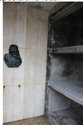
Particolare disposizione loculi
