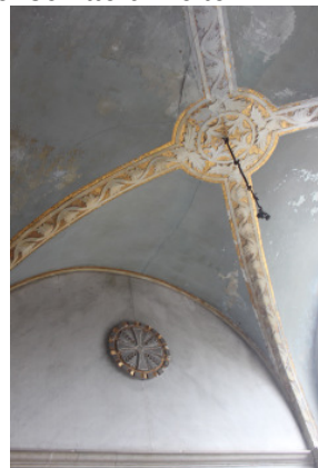
Particolare del soffitto a volte
