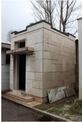
Fronte del manufatto
